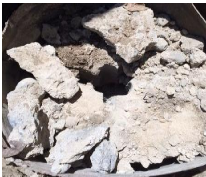
Рисунок 28 – Разрушения монолитных бетонных блоков зарядом ГХП
